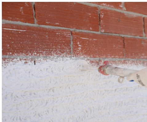
Εφαρμογή Intomar Mono με μηχανή κονιαμάτων
