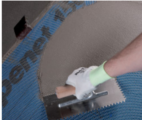
Laying Mapelastic on Mapenet 150
