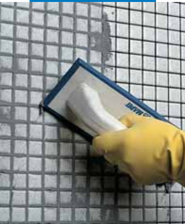
Αρμολόγηση υαλοψηφίδας (σε μπάνιο-λουτρού) με σπάτουλα
