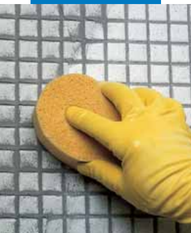
Φινίρισμα αρμολόγησης υαλοψηφίδας με σφουγγάρι
