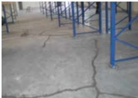
Οι ενδεχόμενες ρωγμές στο υπόστρωμα, διευρύνονται σε τομή τουλάχιστον 10x10mm, κόβονται εγκάρσιως ανά 30cm, και στοκάρονται με Epoxol® Putty σε αναλογία 2A:1B
