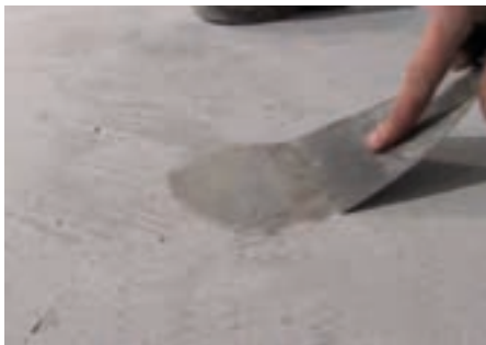
Τοπικά στοκαρίσματα οπών και ατελειών με εποξειδικό στόκο Epoxol® Putty σε αναλογία 2A:1B
