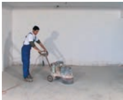
Σχολαστικό τρίψιμο της επιφάνειας με μηχανή μωσαϊκού
