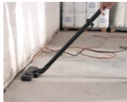
Σκούπισμα των υπολειμμάτων και της σκόνης με ηλεκτρική σκούπα υψηλής απορροφητικότητας
