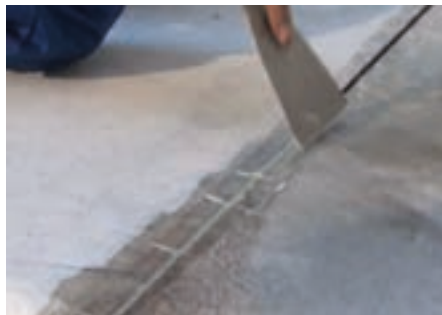
Σφράγιση αρμών βιομηχανικού δαπέδου με Epoxol® Putty σε αναλογία 1A:2B, με σκοπό να επιτευχθεί ελαστικότητα
